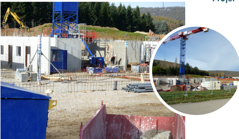
Aperçu du chantier sur le site du futur hôpital de Lavelanet le 7 décembre 2023.
